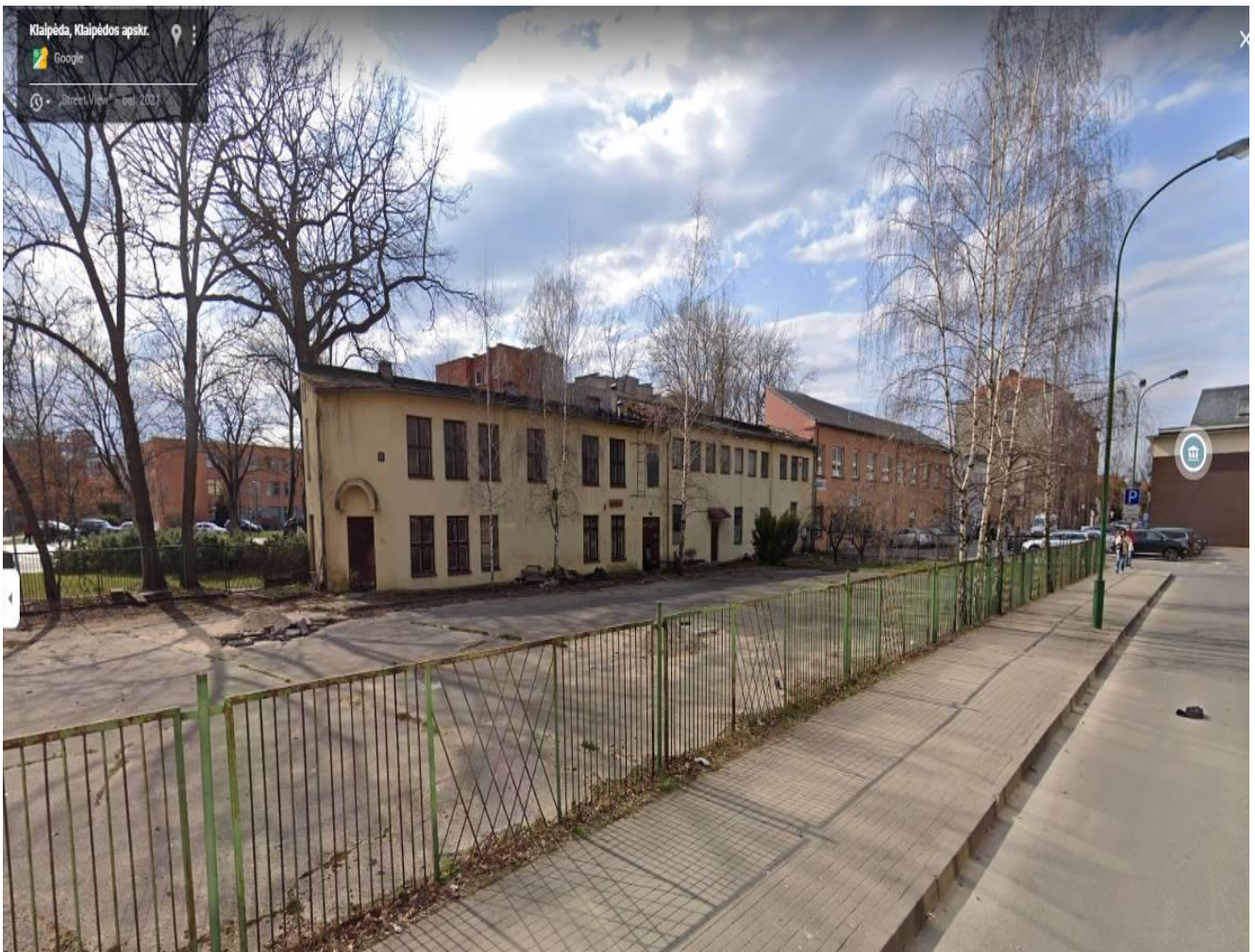
Rekonstruojamas pastatas (sandėlis).
